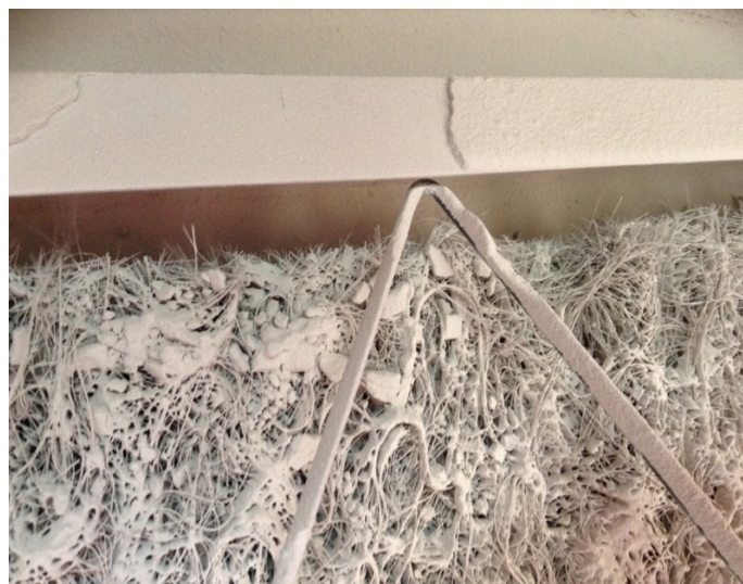
図 39 隙間部分の拡大写真(圧力損失 500Pa)
